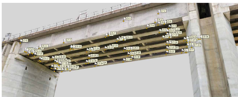
1C. Esempio di georeferenziazione difetti sul digital twin
